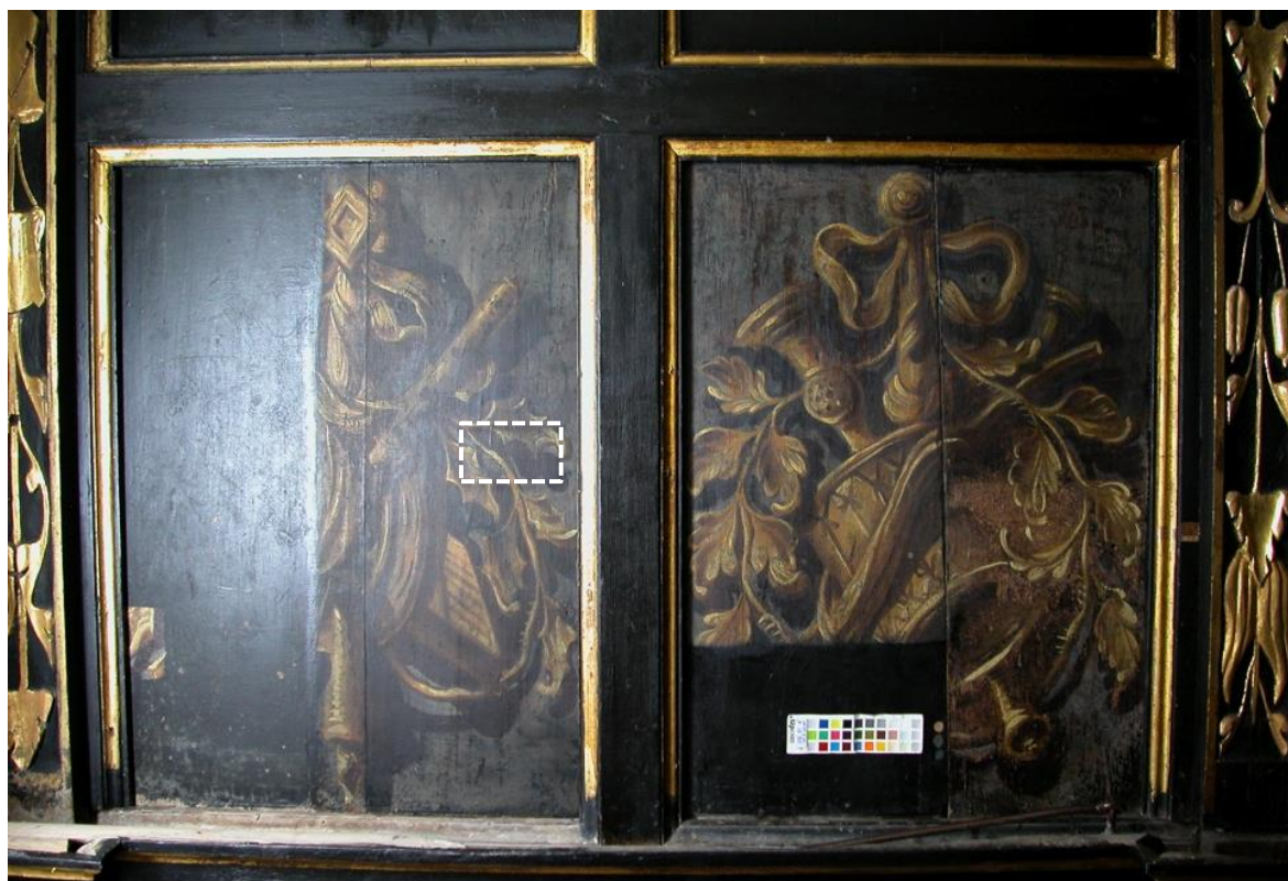
Fig. 13. Bij een kleurhistorische inventarisatie is gestart met een klein kleurenvenster, omdat in strijklucht dikke lijnen onder de effe zwarte vlakken zichtbaar zijn. Bij de kleurverkenning die daarna is uitgevoerd, is het kleine venster vergroot. Dit om de decoratie beter te kunnen begrijpen en op zijn kunsthistorische waarde te kunnen inschatten.
